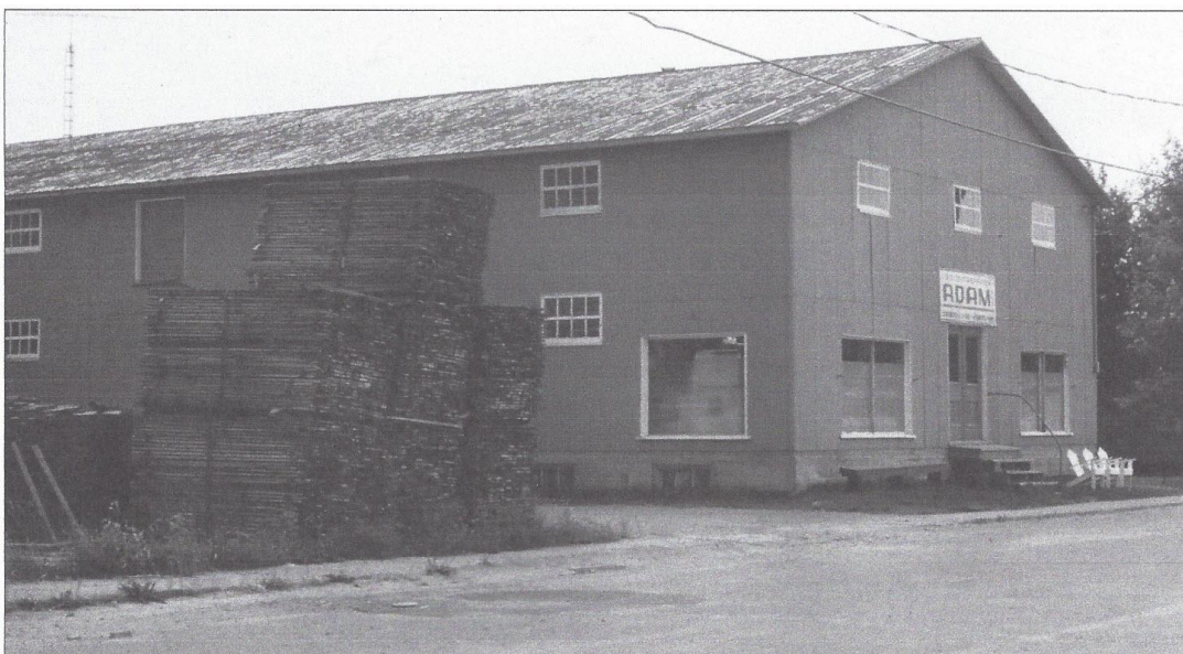
L'ancien entrepôt du magasin de Gatien Trempe, aménagé par Bernard Charland en atelier de couture et acquis, en 1974, par Paul Adam. Coll. Jean-Marie St-Pierre.
