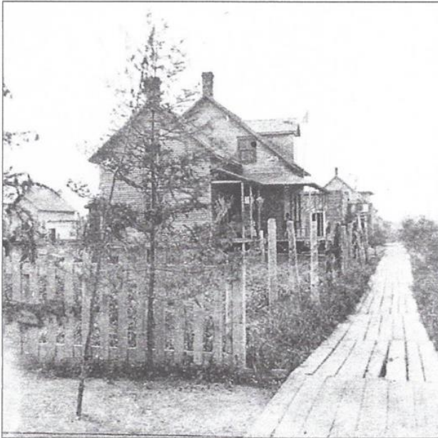
Maison de Cyriac Kirouac. Notez le trottoir en bois
