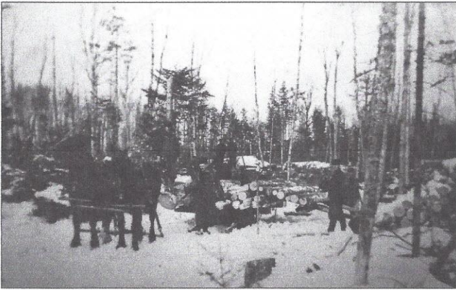
Les chantiers, 1913. Coll. Jean-Marie St-Pierre,
