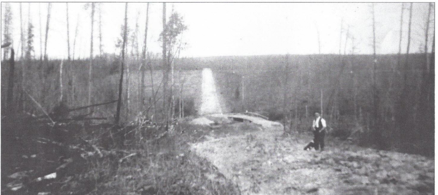
Ouverture d'un chemin à Moose Park.
