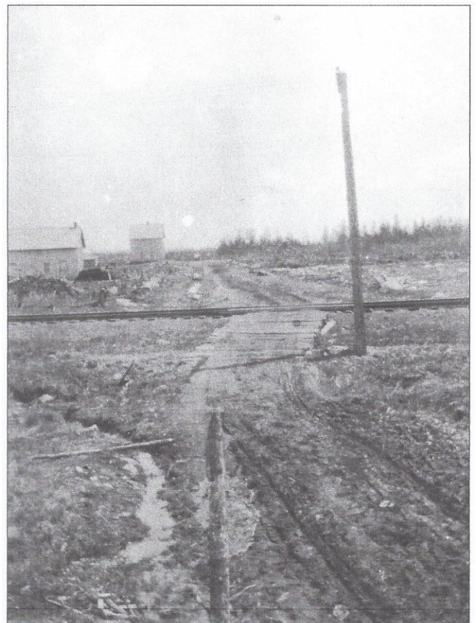
Ouverture du chemin du rang Belgique avec le passage à niveau, vers 1916.
