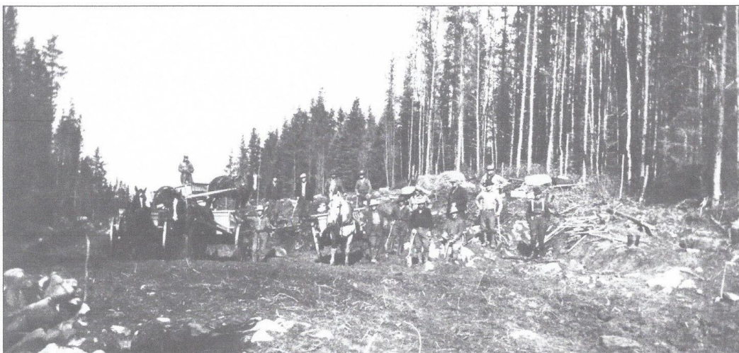
Ouverture d'un chemin à Manseau
