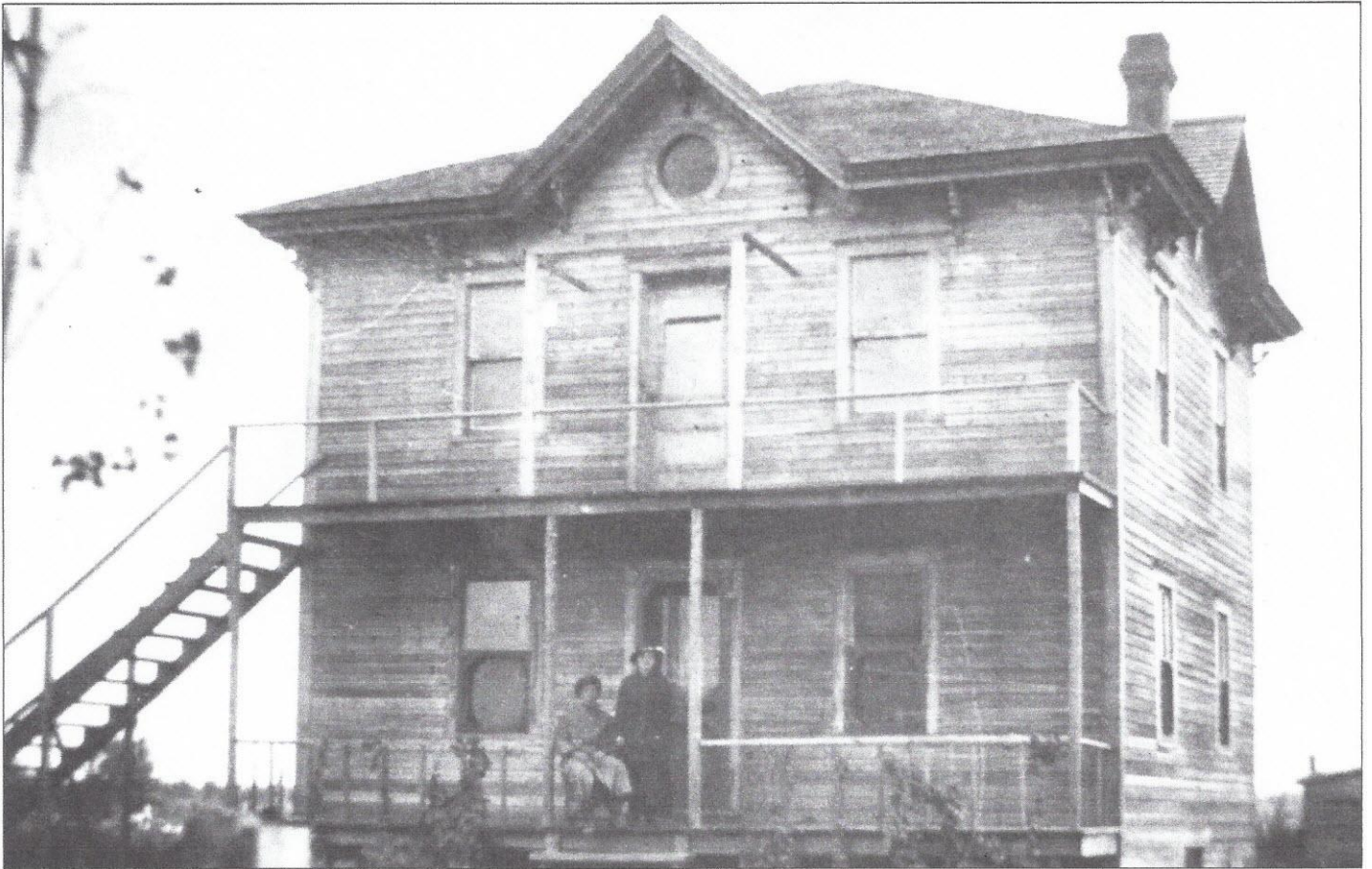
Maison à deux étages construite par Odilon Cajolet vers 1916 sur la rue Saint-Albert. Coll. Jean-Marie St-Pierre.
