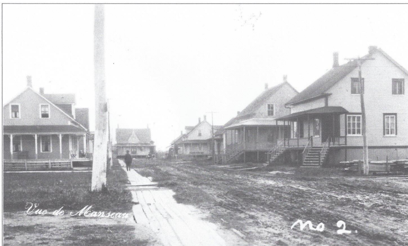
La rue Saint-Georges, au sud de la voie ferrée, vers 1918. La maison de droite appartient à Joseph Trempe. La seconde maison à partir de la droite deviendra la propriété de Dame Veuve Napoléon Paris en 1924 et abritera la banque.
