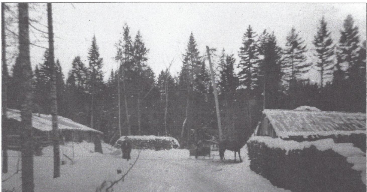
Chantiers pour le compte d'Alcide Savoie vers 1913. Coll. Jean-Marie St-Pierre.
