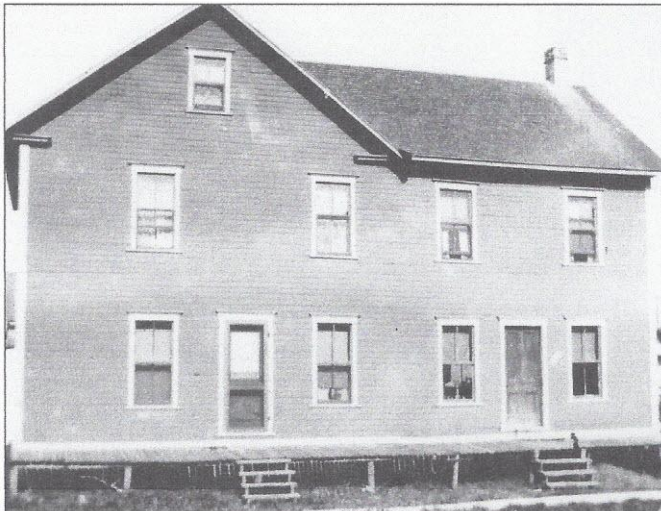
Édifice de la rue Saint-Albert, appartenant à Joseph Sylvestre. La partie de droite, en bas, servait de salle publique. Napoléon Gagnon transformera cette bâtisse en hôtel et lui donnera le nom de Lustucru. Avant d'appartenir à Joseph Sylvestre, cette grande maison avait également servi d'école, avant la construction du Couvent en 1913. Coll. Hélène Savoie.
