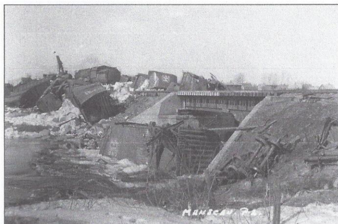
Déraillement de février 1956 qui aurait endommagé le Pont des Chars, préparant indirectement de déraillement d'avril 1956 (ci-dessous). Coll. Armand Anttil.
