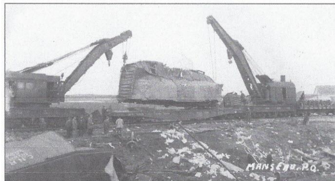
Déraillement du 4 avril 1956. Remise en état des lieux.
