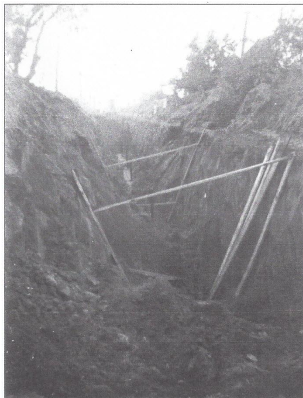
Aqueducs et égouts, 1957.
